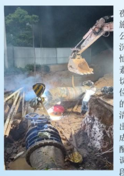
5月11日深夜，汶仁配水厂施工期间，工程公司干部职工在沉沉夜幕中紧张忙碌着，有条不紊地对原水管进行切割、修整、调位。经过近8小时的奋战，至次日清晨6时半，进、出水管安装完成，标志着汶仁配水厂即将进入安装调试、试运行阶段。（秦天乐）
