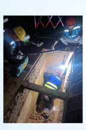
5月11日深夜，汶仁配水厂施工期间，工程公司干部职工在沉沉夜幕中紧张忙碌着，有条不紊地对原水管进行切割、修整、调位。经过近8小时的奋战，至次日清晨6时半，进、出水管安装完成，标志着汶仁配水厂即将进入安装调试、试运行阶段。（秦天乐）
